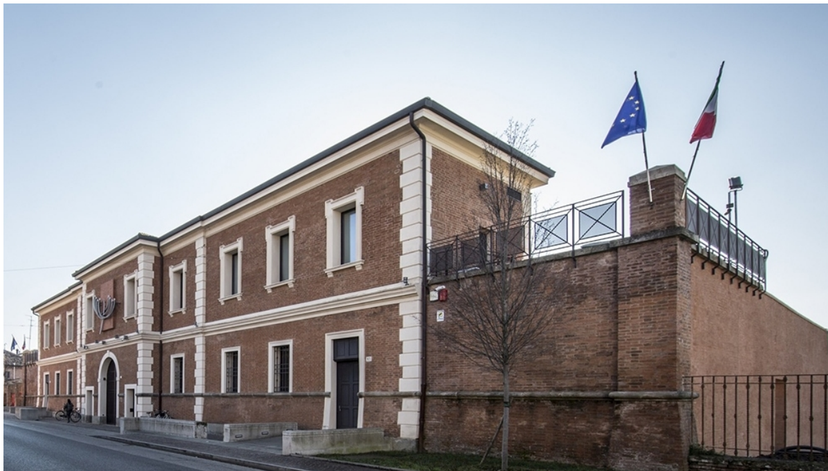
Здание Музея итальянского иудаизма
