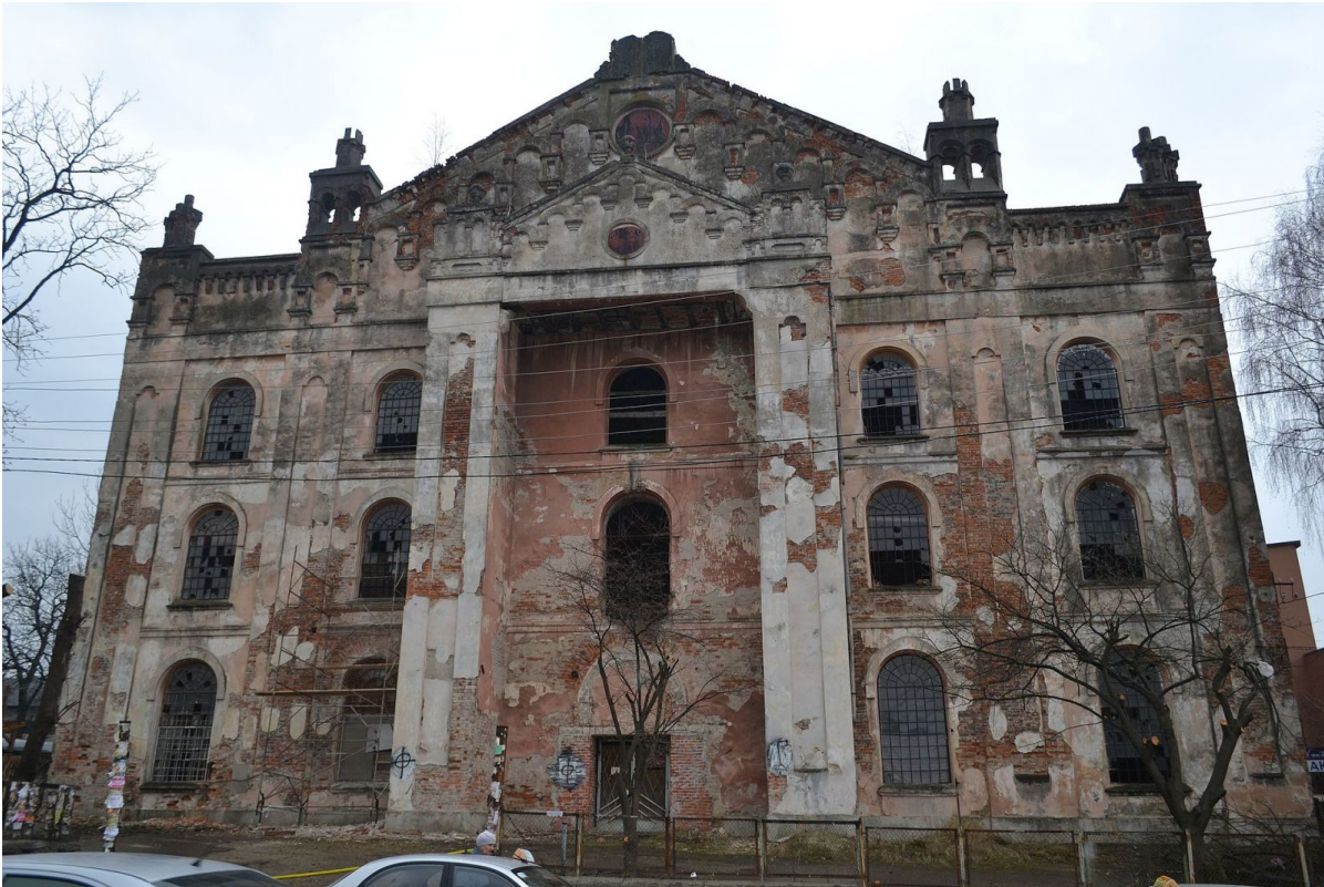
Здание до реконструкции
