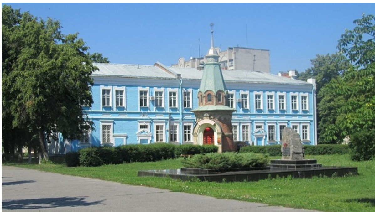
Здание бывшего управления НКВД в Кременчуге
