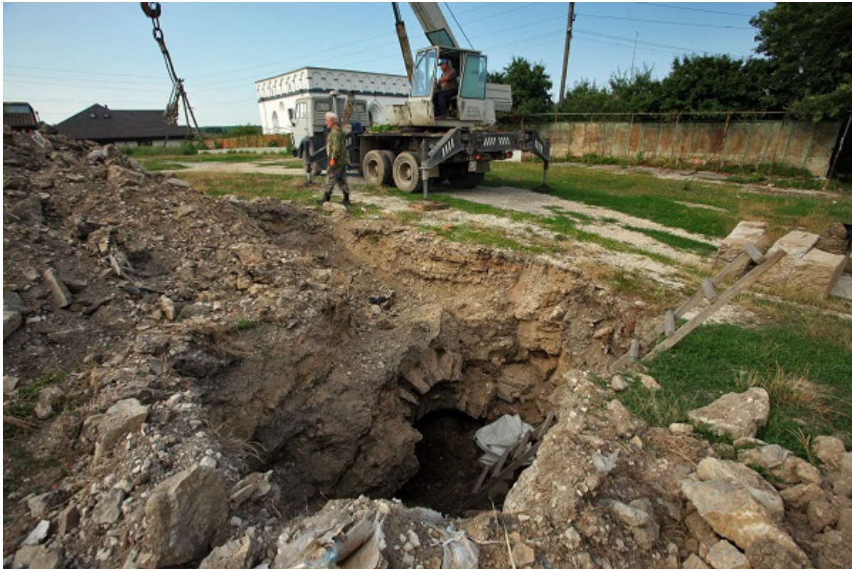
Вход в подвал
