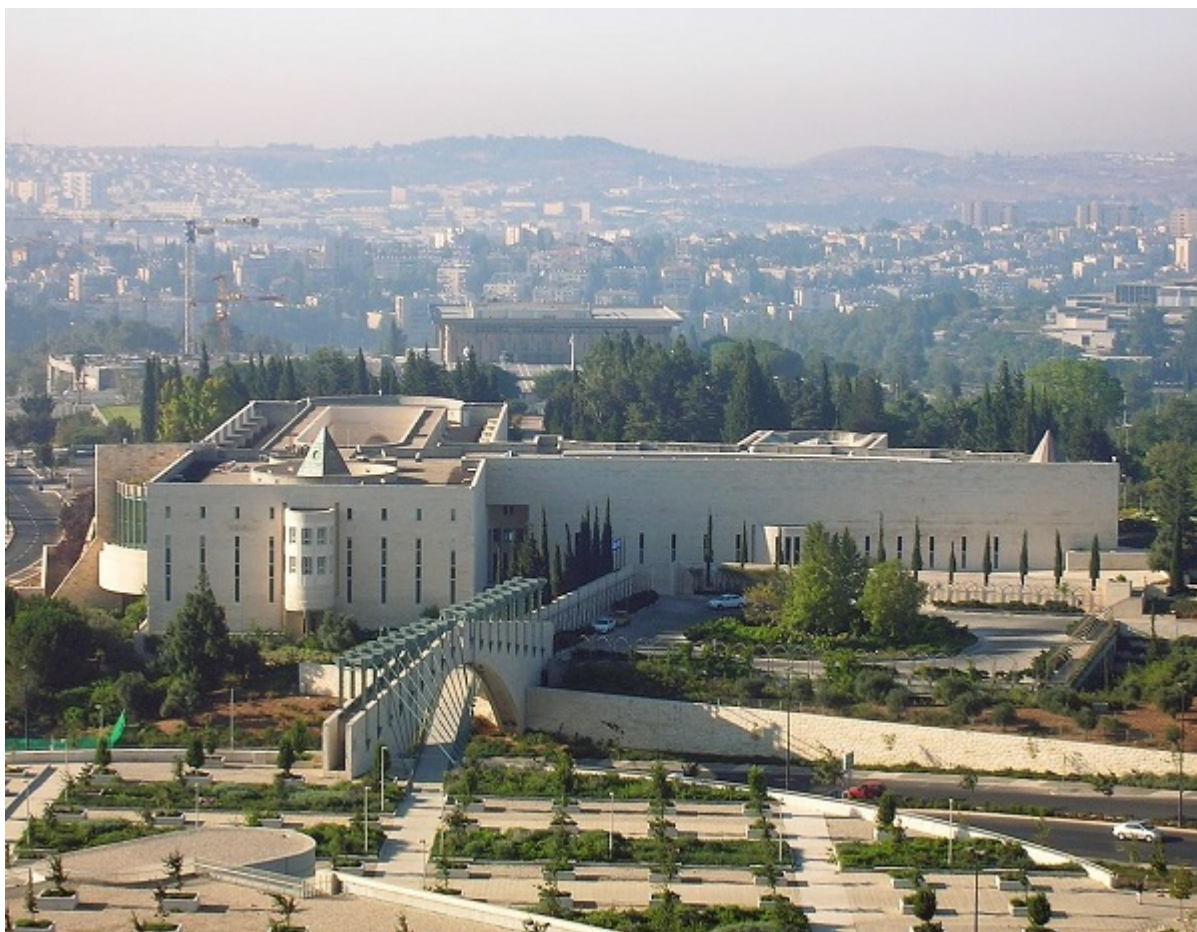
Здание Верховного суда Израиля в Иерусалиме
