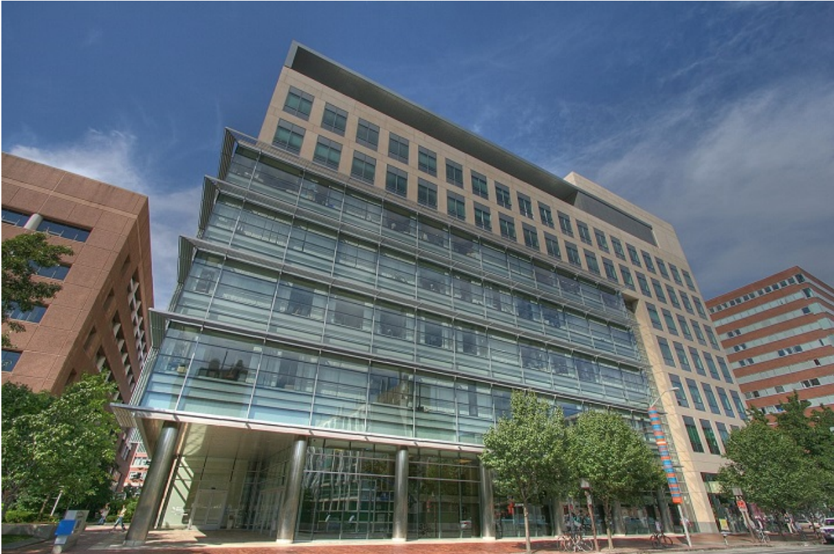
Здание Broad Institute, Массачусетс
