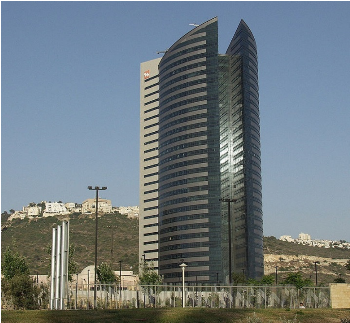
Штаб-квартира Електричної компанії в Хайфі
